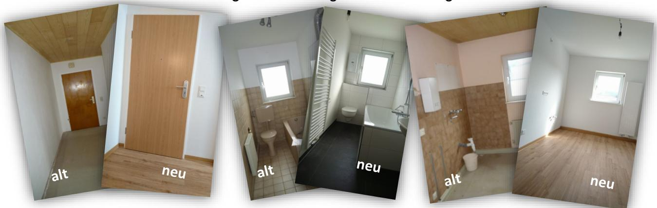
Es sind helle freundliche Räume mit Vinyl-Design-Bodenbelägen entstanden. Das Bad wurde neu gefliest, alle Sanäreinrichtungen erneuert, Heizkörper und Durchlauferhitzer ausgetauscht. Die Elektroinstallationen sind einschließlich eines neuen Sicherungskastens und zusätzlichen Steckdosen und Lichtschaltern auf einen modernen Stand gebracht worden. Die Heizungsanlage erlaubt eine komfortable Wärmeregulierung der Räume.
